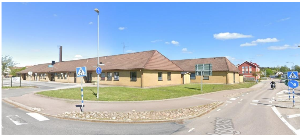
Bild 2. Befintlig vårdcentralbyggnad från korsningen Centrumgatan – Parkgatan.
