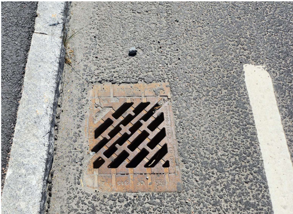
Figur 5. Befintlig dagvattenbrunn på väg 1916. (Platsbesök 2023-06-10)
