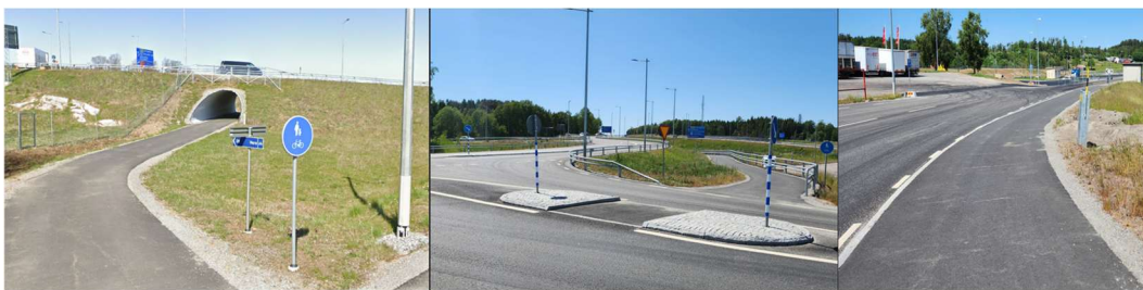
Figur 4. GC-tunnel under väg 181 till vänster (Google Maps 2023-06-13), GC-passage över väg 1916 i mitten (Platsbesök 2023-06-10) och 3 meter bred GC-bana på väg 1916.(Platsbesök 2023-06-10).
