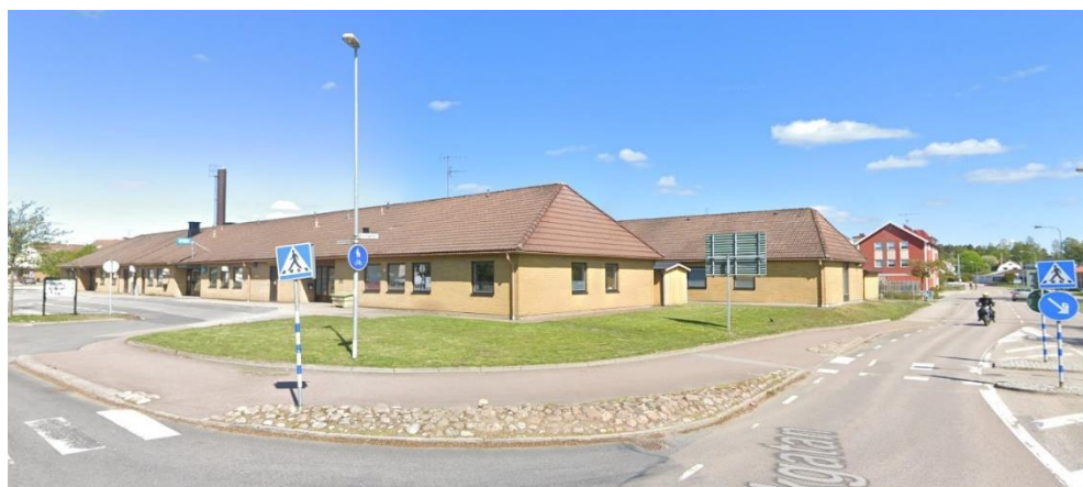
Bild 2. Befintlig vårdcentralbyggnad från korsningen Centrumgatan – Parkgatan.
