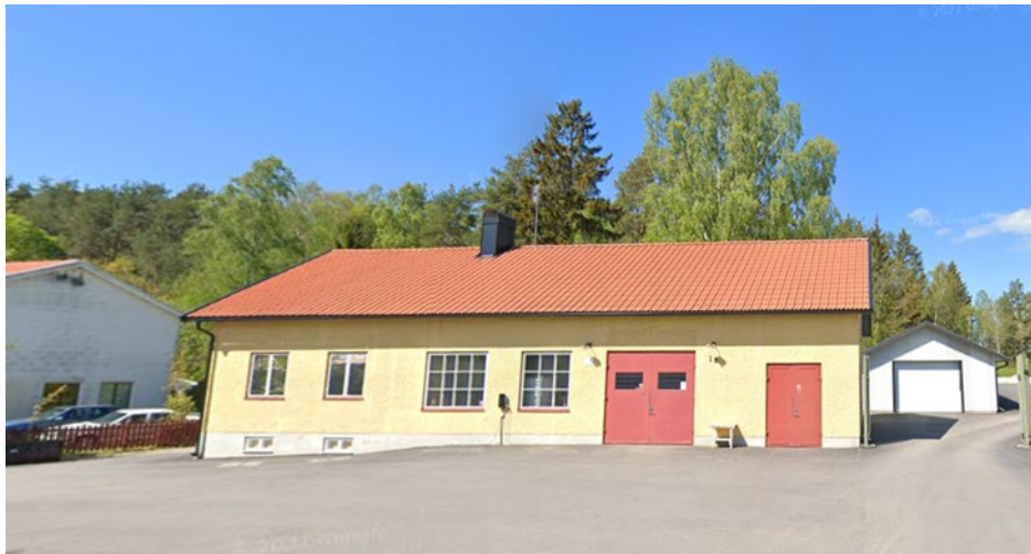
Bild 7: Byggnaden på Flaskeberget 2.
