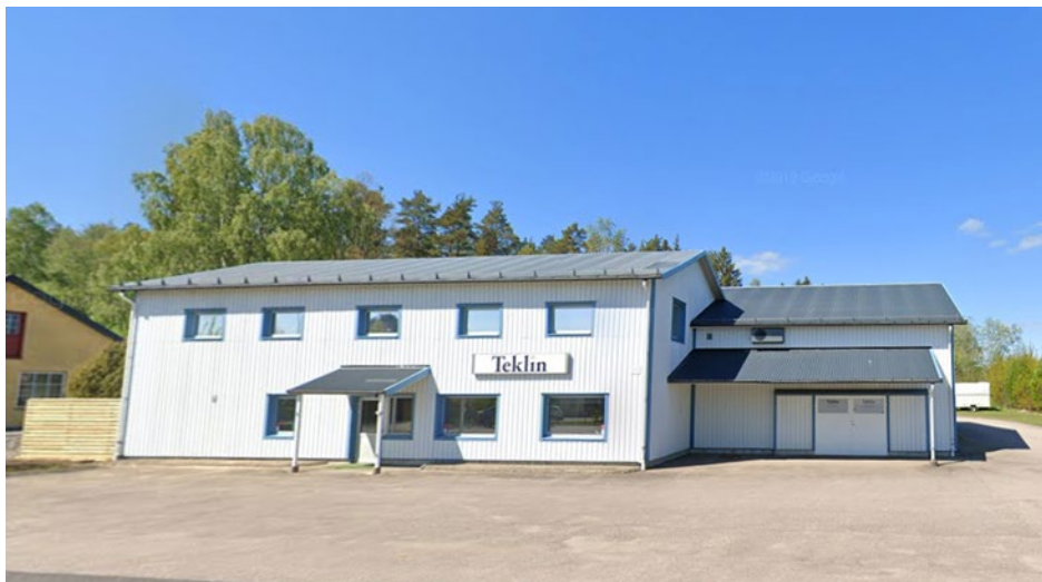
Bild 6: Byggnaden på Flaskeberget 1.
