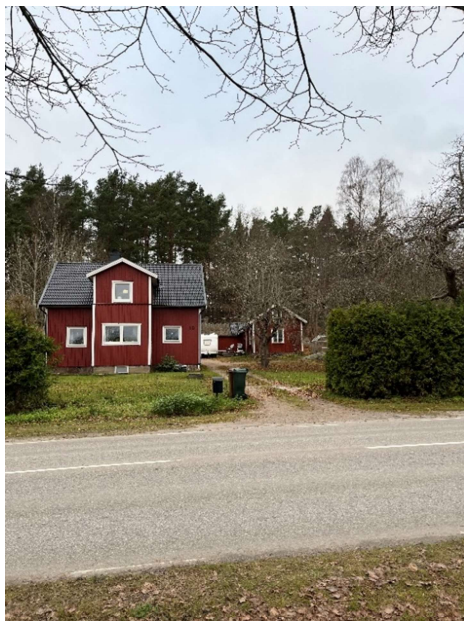
Figur 13. Bild tagen invid Stockholmsvägen. Vy mot norr. Berg i dagen inom tomtmarkens östra del.
