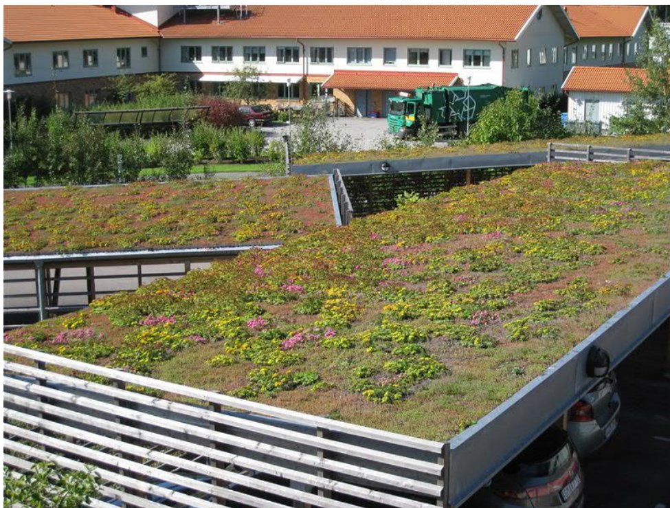
Figur 44. Grönt sedumtak på garagebyggnad i Kungsbacka. Bildkälla: VegTech AB.
