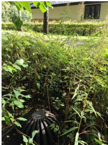
Figur 7. Befintlig kupolbrunn i södra lågzone. Korsnåbbsgatan 12 i bakgrunden.
