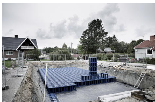
Figur 37. Körbar dagvattenkassett samt anläggande av kassettsystem. Bildkälla: Wavin.se
